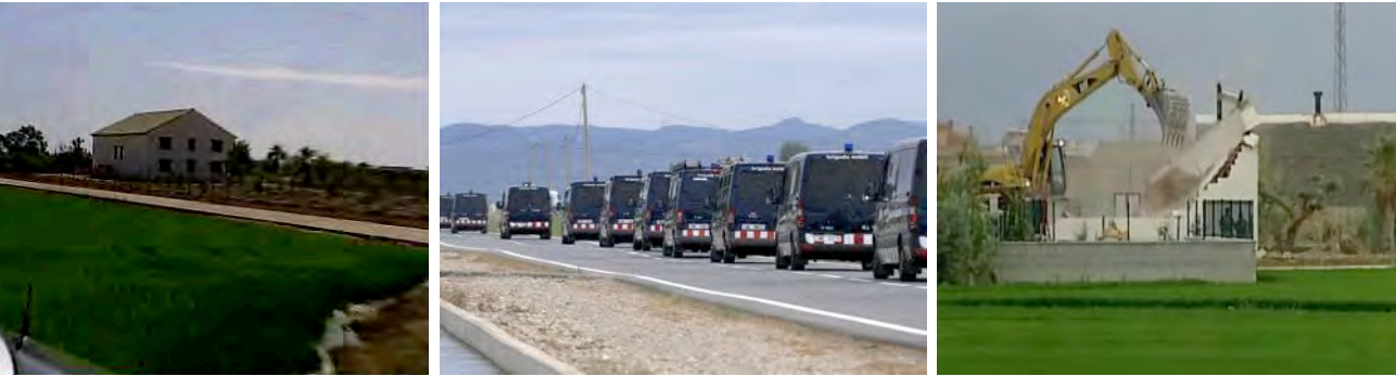
Figura 8. Seqüència de l'ordre de demolició d'un habitatge il·legal
